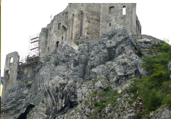
Sanácia hradného brala pod hradom Strečno
