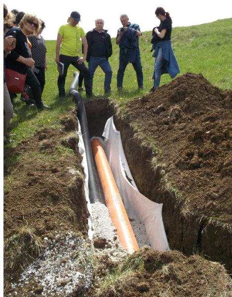
Príprava odvodňovacieho rigolu
