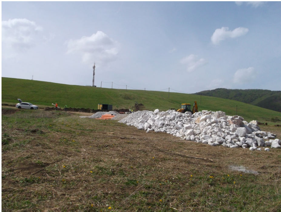
Pripravený materiál k drenážno-stabilizačným rebrám
