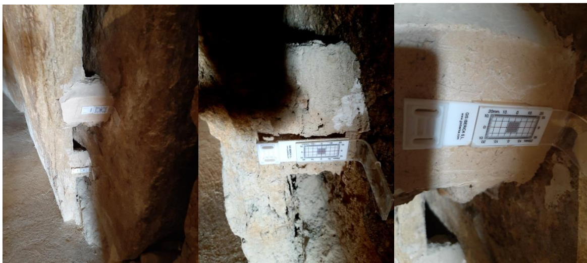
Jeden z monitorovaných vertikálnych blokov dolmenu Menga. Kým horný extenzometer nevykazuje žiadny pohyb, dolný zaznamenal pootočenie.
